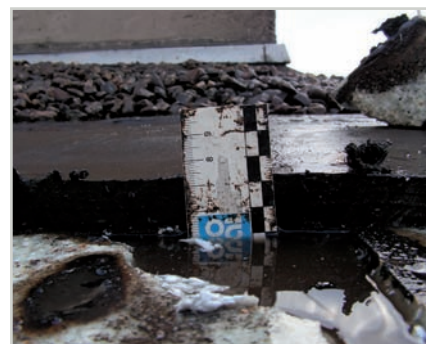
Bestandsaufnahme des Daches
