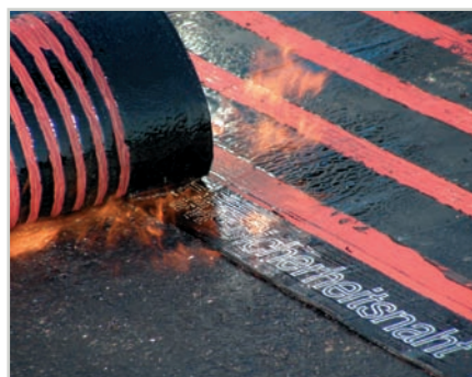
Lagesicherung durch THERM-Streifen
