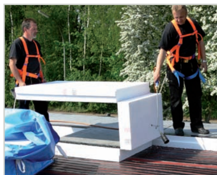
Verlegung POLAR-EPS
