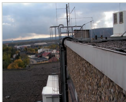
gefälleloses Dach mit Kiesauflast
