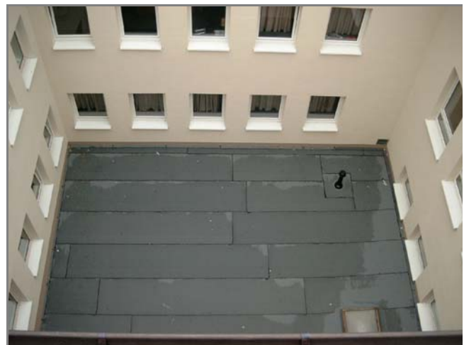
Innenhof nach der Sanierung
