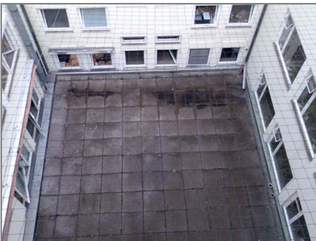
Innenhof vor der Sanierung
