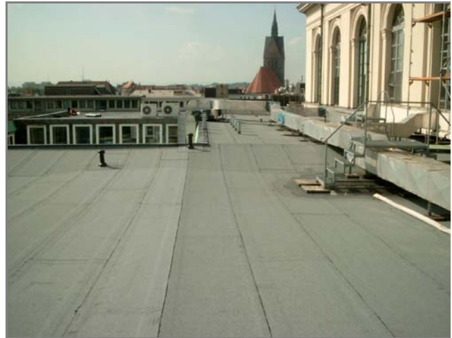
Südflügel nach der Sanierung
