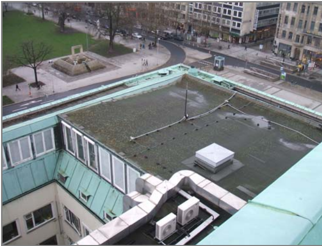
Südflügel vor der Sanierung
