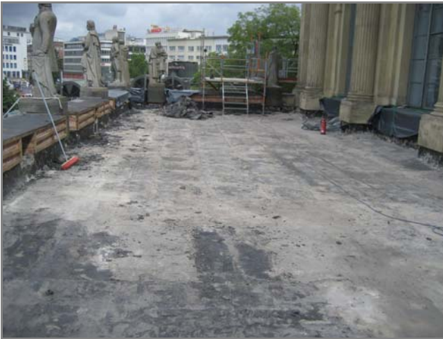
Laves-Balkon nach Abriss
