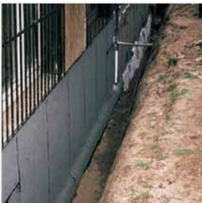
Eine zweilagige Abdichtung erhöht die Sicherheit.
