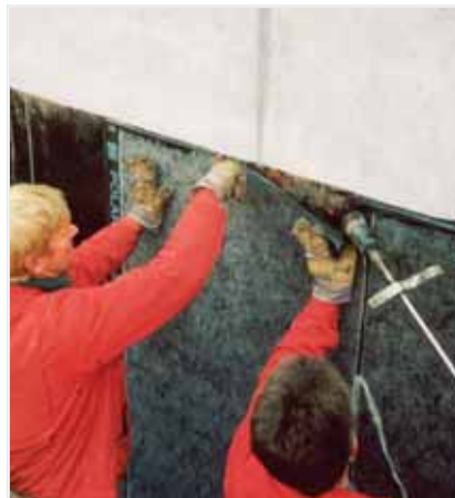
Außenwandabdichtung wird vollflächig angeschweißt.
