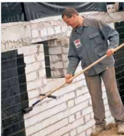
Kaltbitumen-Voranstrich wird gut deckend aufgebracht.
